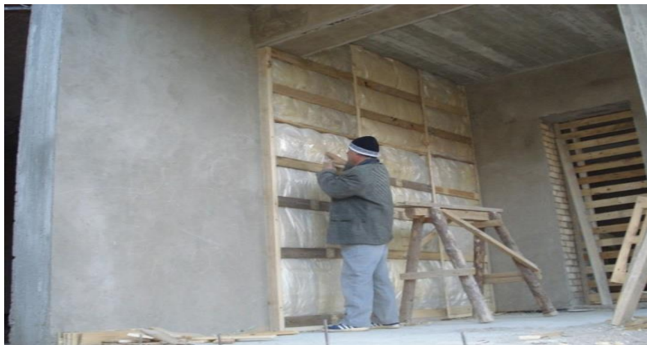
Рис-2. Утепление наружных стен рулонным теплоизоляционным материалом.
